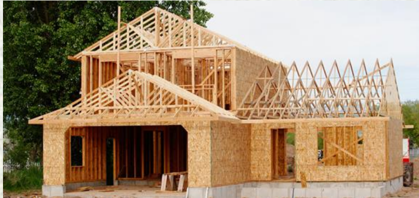
Figura 01: Construção feita em wood frame.
